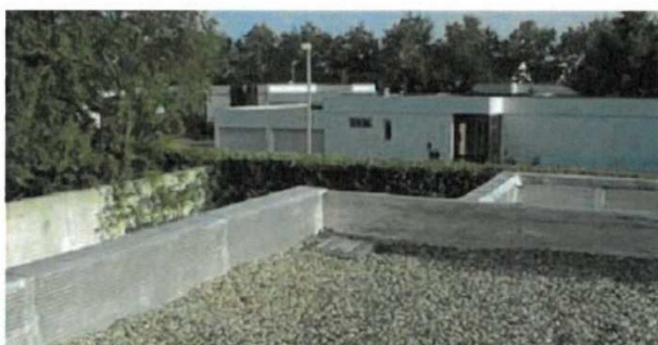
Figure 51 : Toiture-terrasse stockante (Communauté Urbaine du Grand Lyon, 2008)
